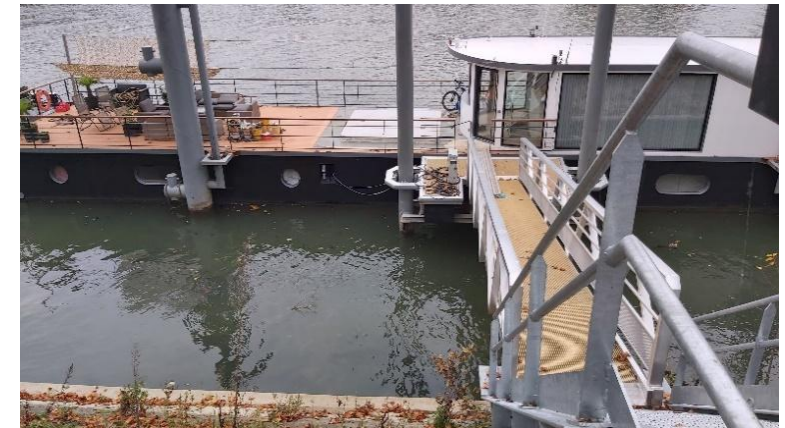
Gardes montantes et descendantes , destinées à amortir les mouvements du bateau et à éviter les chocs
