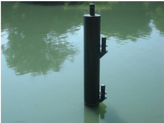
Duc d'albe : Structure isolée du quai, assurant un amarrage plus souple.
