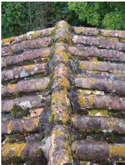
Couverture en tuiles canal avec faîtière scellées
