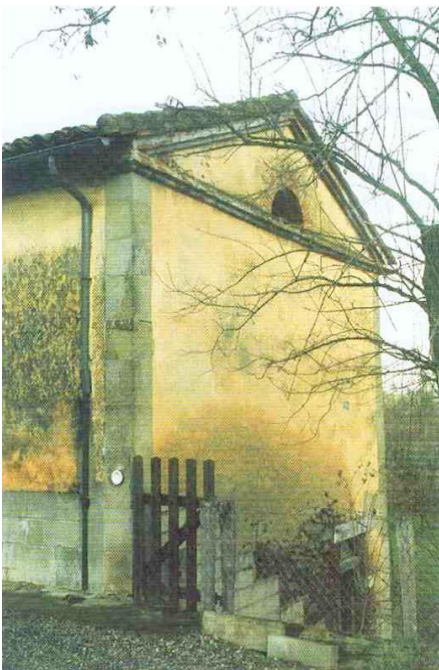
Exemple de désordres causé par l'humidité
