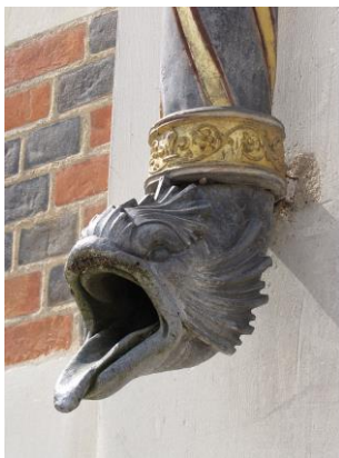
descente d'eau pluviale. Sa base recourbée peut être ornée d'une figure animale.
