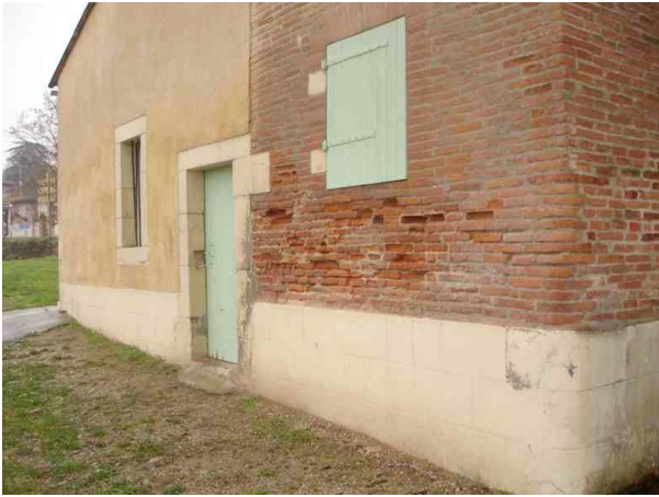
Exemple de de désordres liés aux remontées d'humidité sur des briques apparentes
