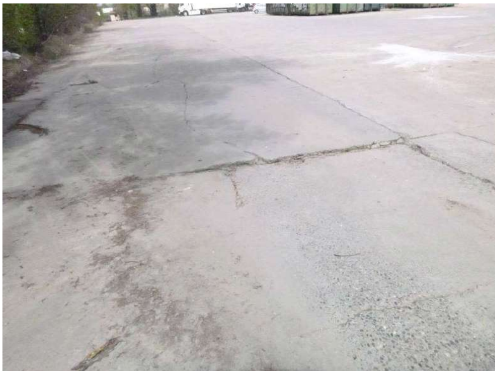
Figure 1 : Fissuration du dallage, éclats de béton.
