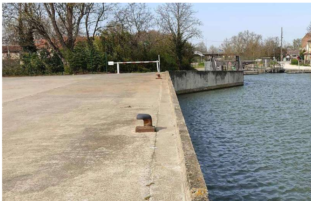
Figure 34 : Bitte d'amarrage présentant quelques traces de corrosion.
