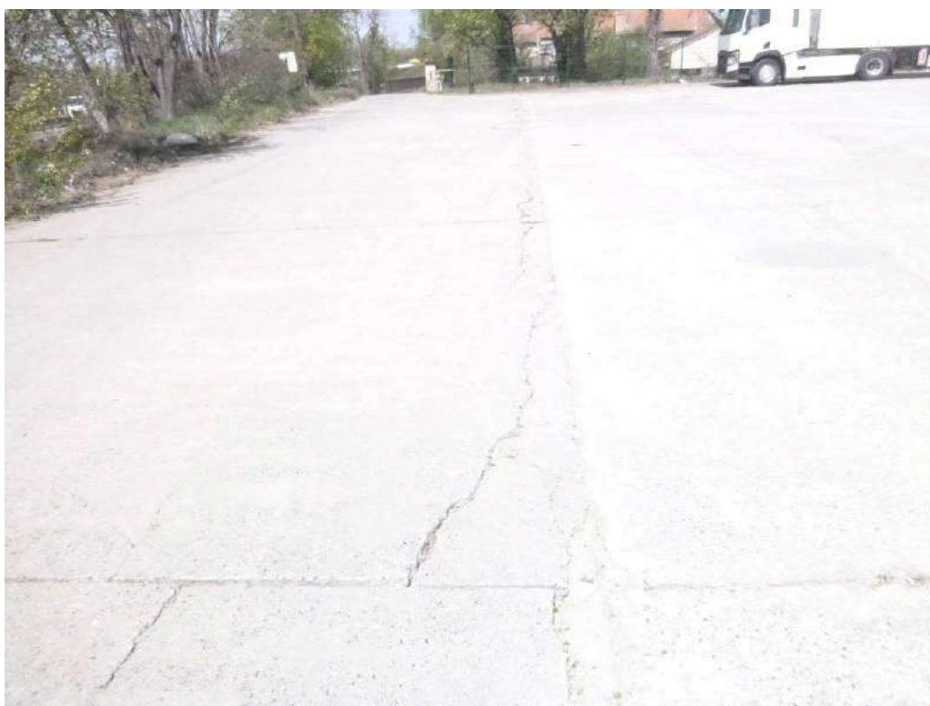
Figure 10 : Fissuration du dallage, éclats de béton.
