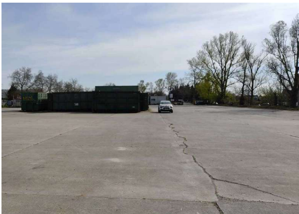
Figure 15 : Fissuration du dallage, éclats de béton.
