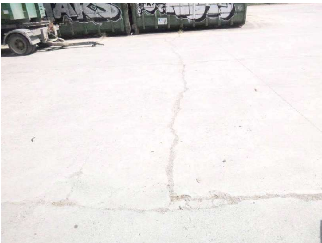
Figure 6 : Fissuration du dallage, éclats de béton.
