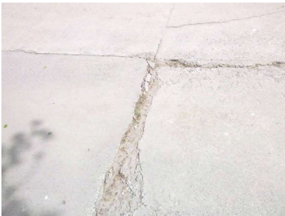
Figure 2 : Eclats de béton.
