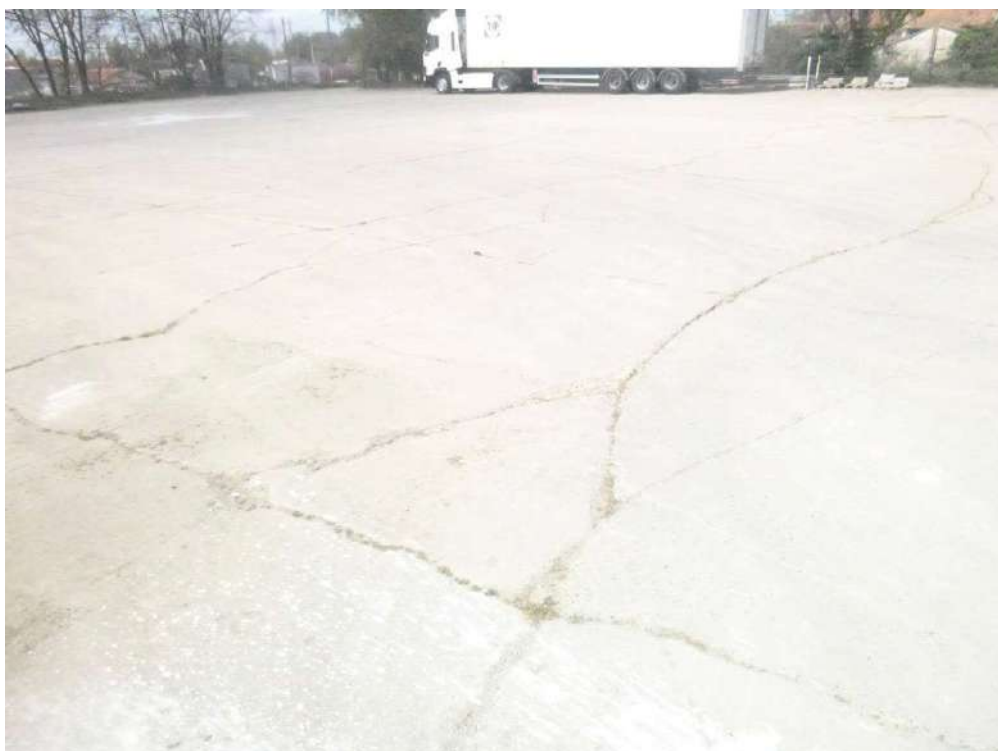
Figure 29 : Fissuration du dallage, éclats de béton.
