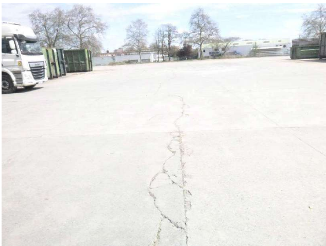
Figure 5 : Fissuration du dallage, éclats de béton.
