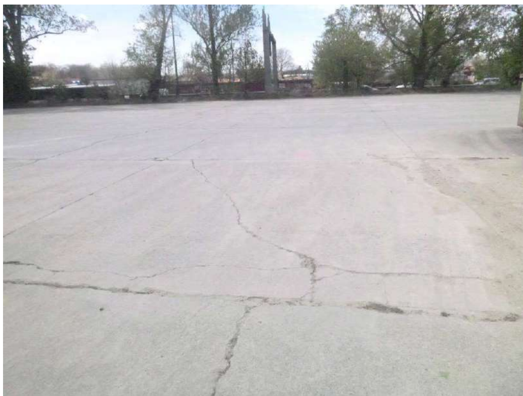
Figure 28 : Fissuration du dallage, éclats de béton.
