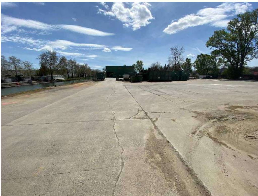
Figure 25 : Fissuration du dallage, éclats de béton aux angles de plusieurs dalles.
