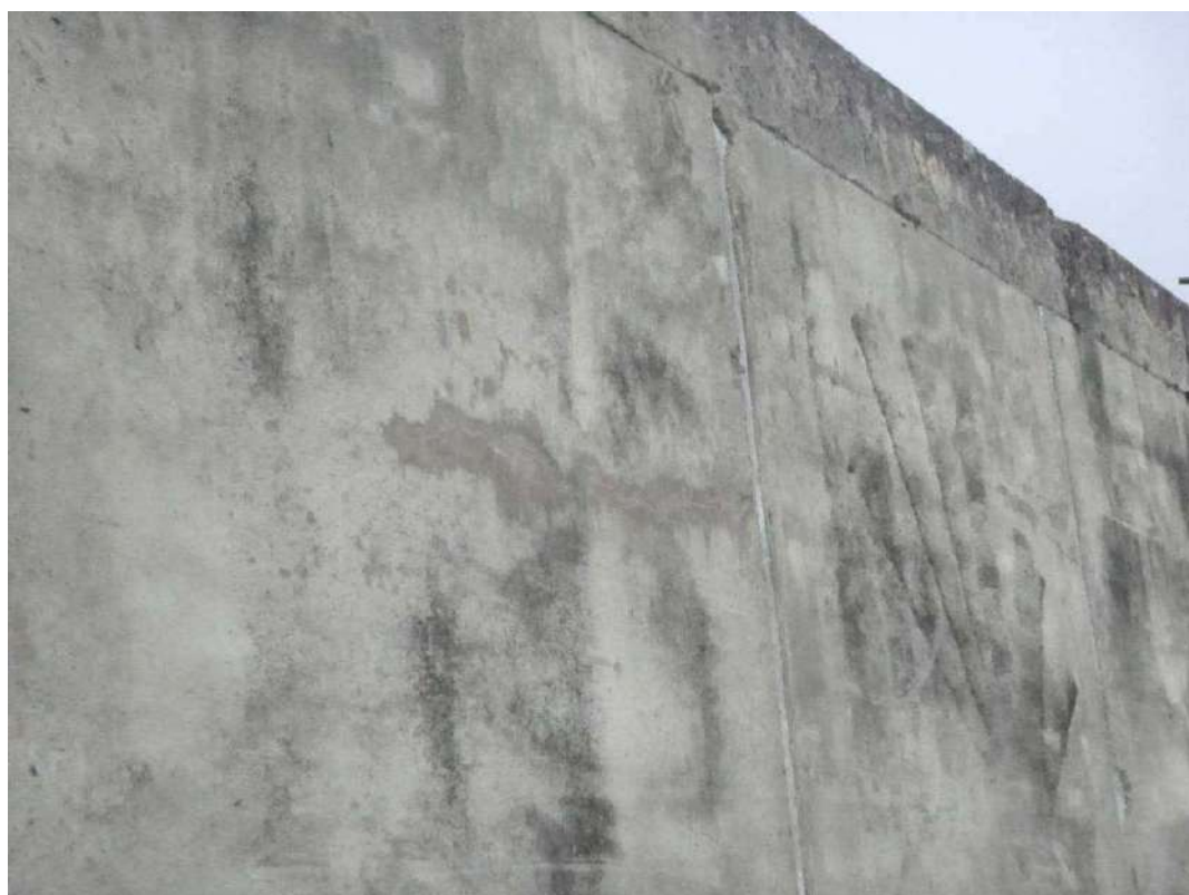
Figure 44 : Microfissure présentant des traces de calcite active.
