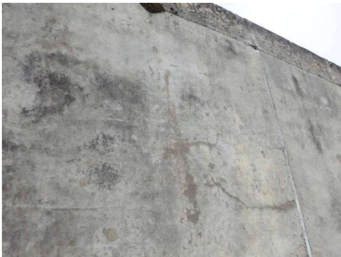
Figure 45 : Microfissure, traces d'humidité.
