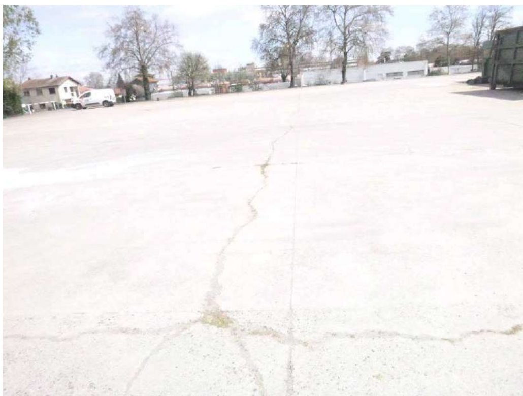
Figure 13 : Fissuration du dallage, éclats de béton.
