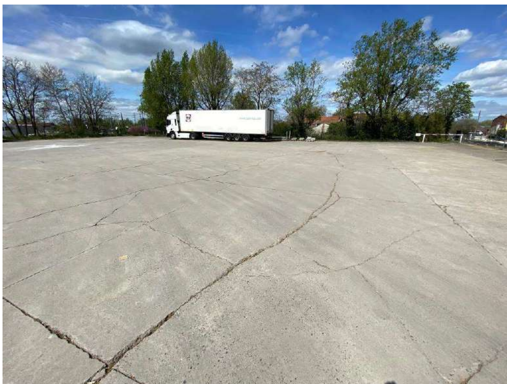
Figure 31 : Fissuration du dallage, éclats de béton.
