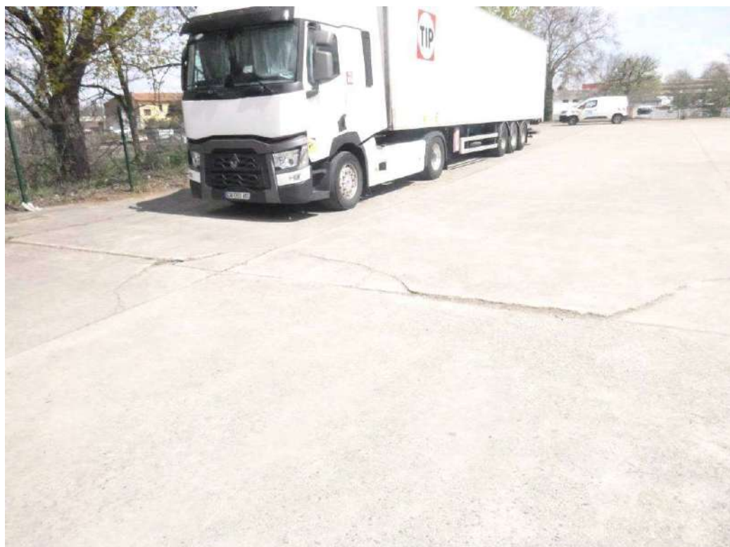
Figure 14 : Fissuration du dallage, éclats de béton.
