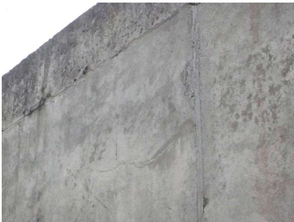
Figure 41 : Microfissure présentant des traces de calcite.
