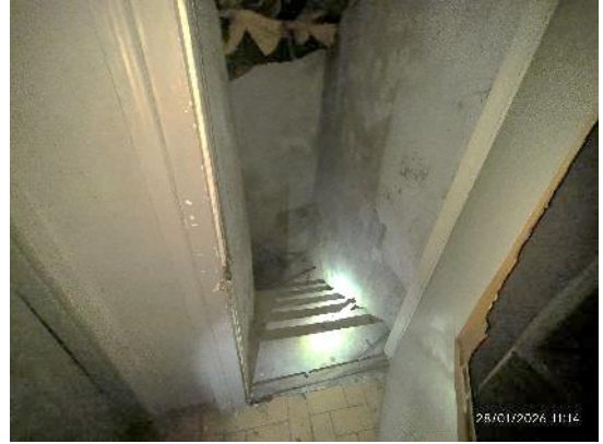
Escalier vers le sous-sol
