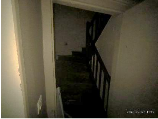
Escalier vers l'étage
