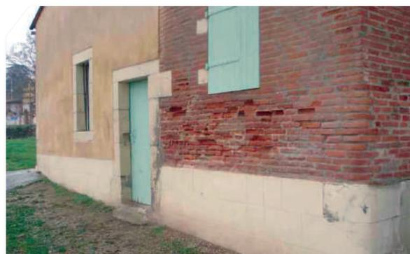
▲ Exemple de désordres liés aux remontées d'humidité sur des briques apparentes
