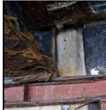
Perte totale de la section du bac acier avec apparition du béton
