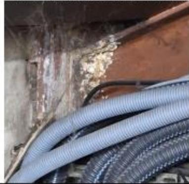
Etanchéité couverture zone du bâtiment sous trottoir ( voirie), visible et dégradée :
