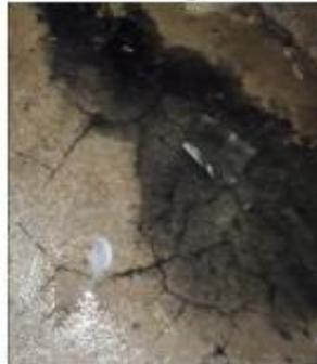
Fissures diverses en plancher bas bureaux (plancher basR+1)
