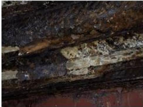
Perte section boulon par corrosion
