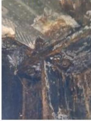
Corrosion très importante assemblage, ossature et bac acier, avec arrivée d'eaux importante.
