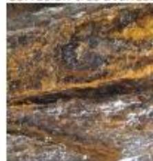
Corrosion très importante assemblage, ossature et bac acier, avec arrivée d'eaux importante.
