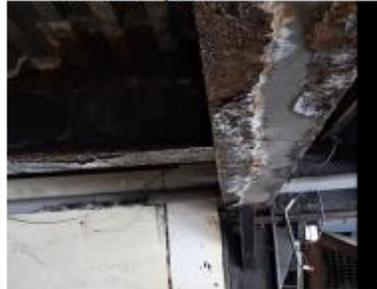
Arrivée d'eau importante, avec perte de section totale et partielle de bac acier
