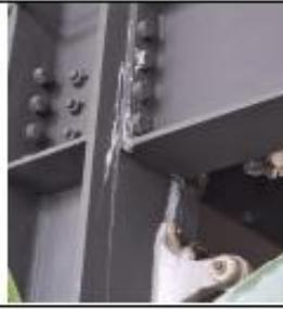
Infiltration angle portique et corrosion :
