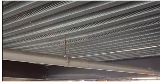
Déformation excessive de structure ( ici bac acier.)
