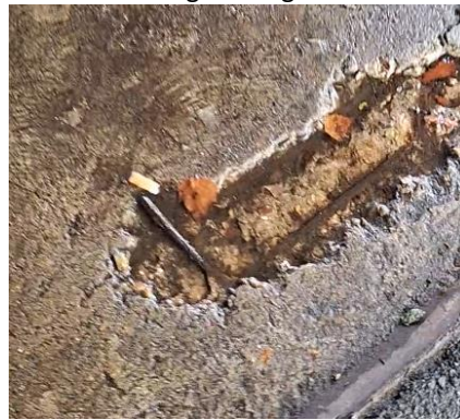
Perte d'enrobage et dégradation des aciers à béton
