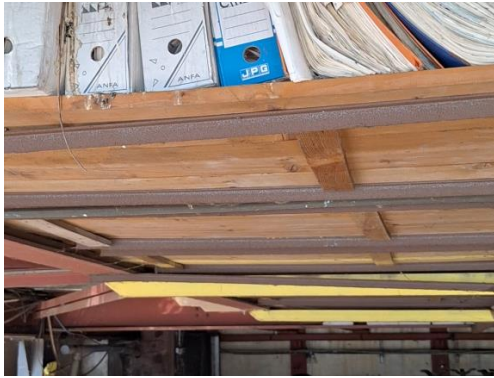
Déformation, excessive du bois.
