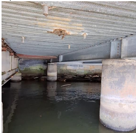
Corrosion et déformation en sous face du plancher le plus bas :
