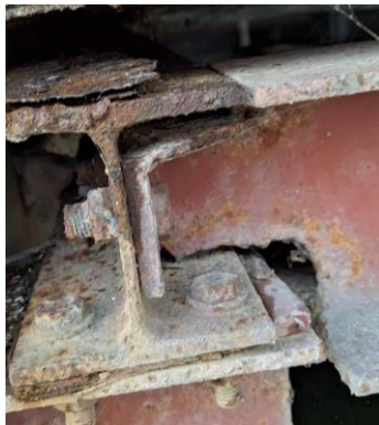
Charpente et assemblages déformés, dégradés, corrodés :
