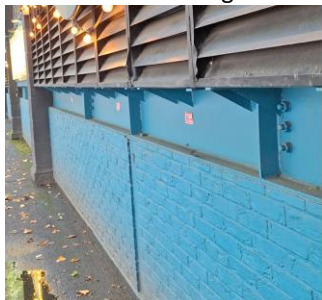
Poutre de rive le long de la facade sur les zone 1/2/3 :
