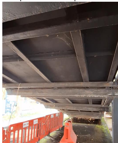
Principe structurel rampe du RDC au R+1 parking :
