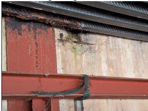
Perte d'enrobage et dégradation des aciers à béton
