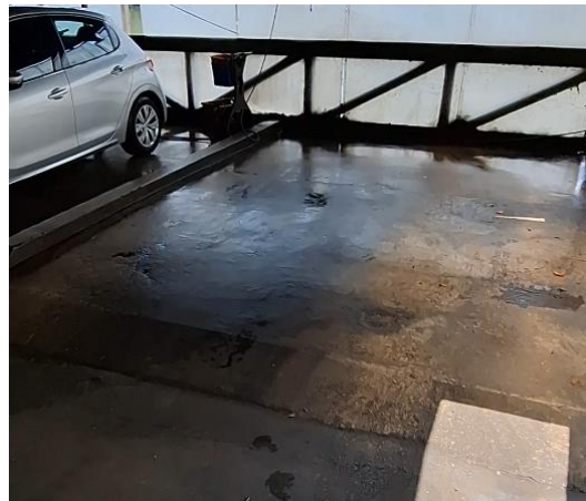
Surcharge à vérifier et gestion des évacuations d'eau à revoir.
