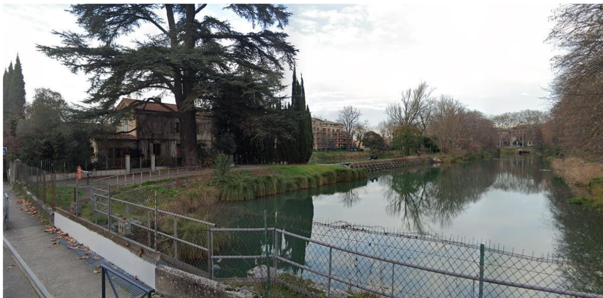
Site du bassin des filtres et de la maison du barragiste
