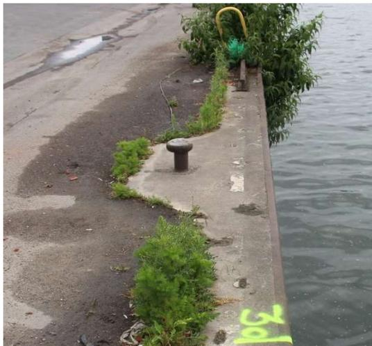
**Photo 5 : Bollard d'amarrage sur massif sur massif béton (BIEF)**
