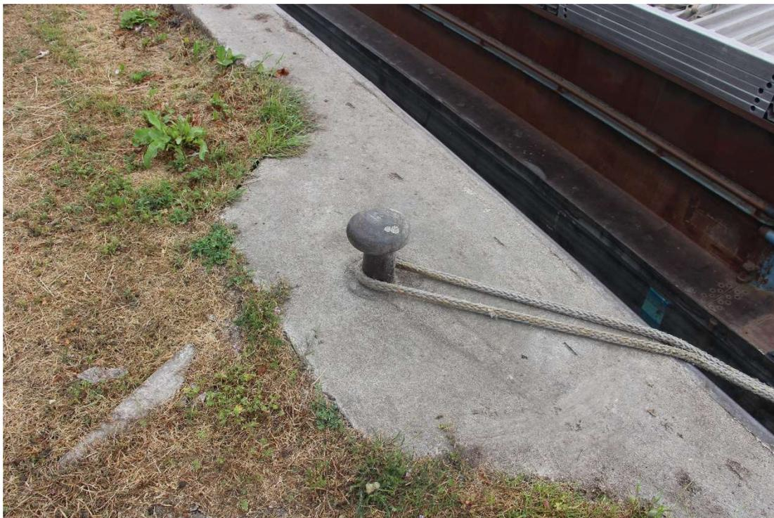
Photo 15 : Bollard d'amarrage sur massif béton (BIEF)
