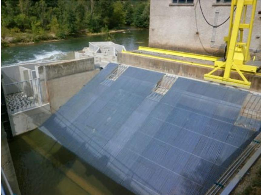
**Fig. 13. Exemple de grille et dégrilleur**
