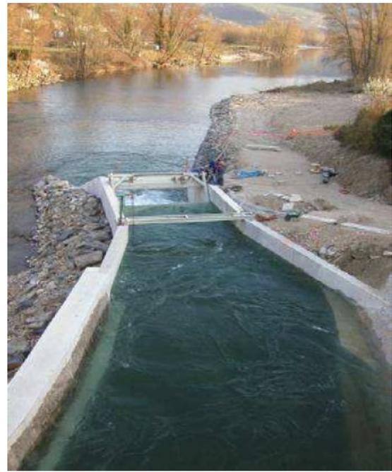
**Fig. 10. Turbine en position de travail avec le chenal amont vide**
