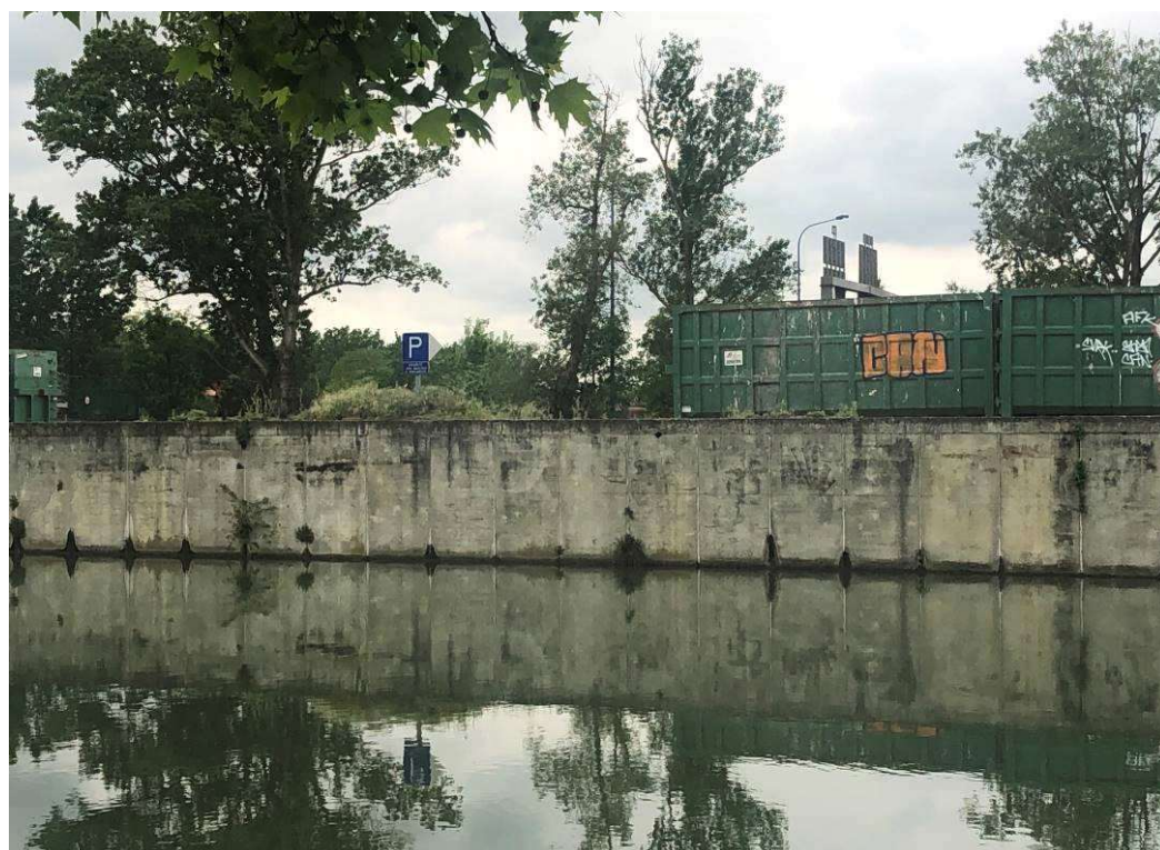
Figure 54 : Vue de la partie E (renseignée sur le plan d'implantation des désordres) du mur de soutènement, présence d'humidité et de végétation le long des joints de dilatation. — Présence d'un panneau de signalisation
