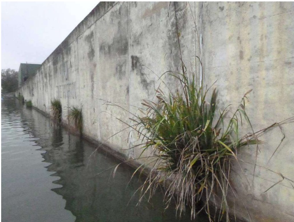
Figure 49 : Vue vers le sud, présence de végétation.
