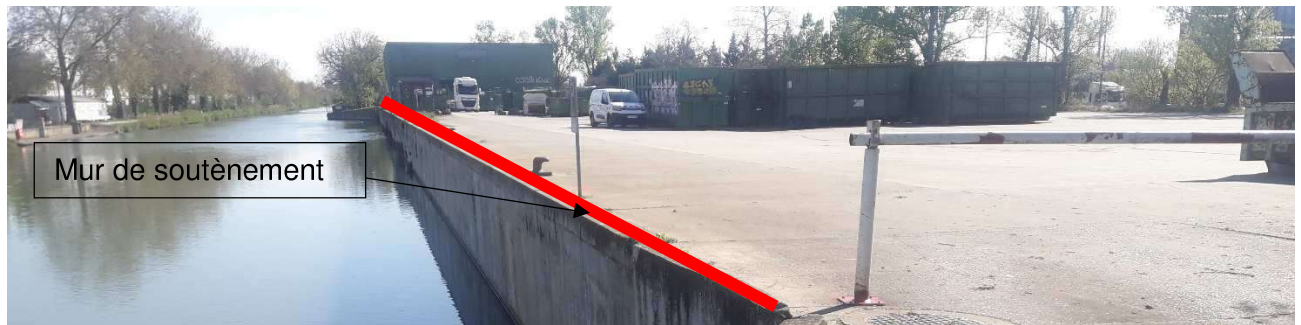
Le mur de soutènement
