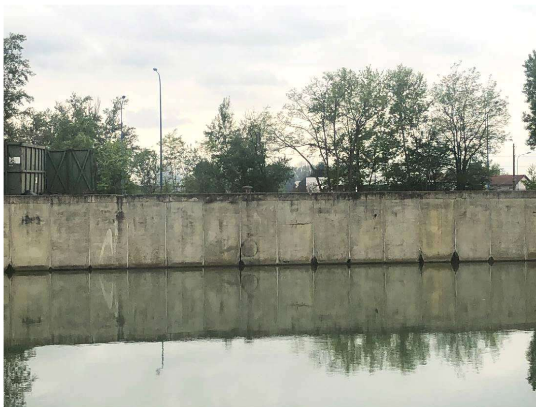
Figure 52 : Vue de la partie C (renseignée sur le plan d'implantation des désordres) du mur de soutènement, présence d'humidité le long du joint de dilatation.
