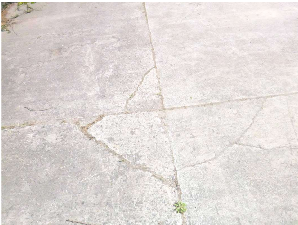
Figure 19 : Eclats de béton aux angles de plusieurs dalles.
