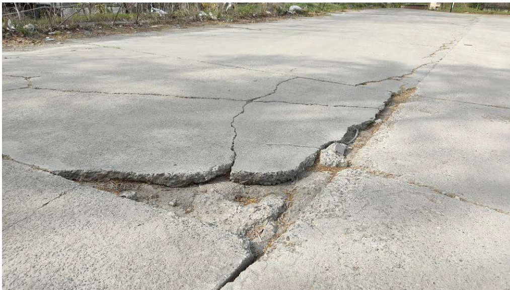
Figure 9 : Fissuration du dallage, éclats de béton et différence de niveau entre les éléments.
