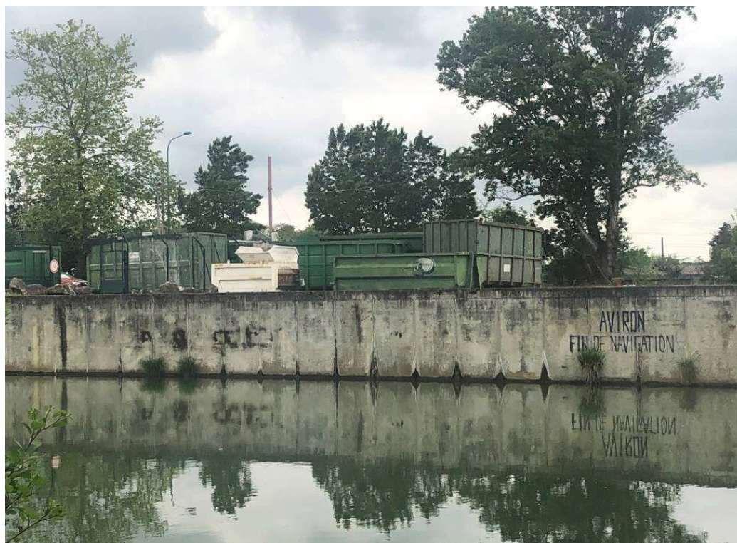
Figure 56 : Vue des parties G et H (renseignées sur le plan d'implantation des désordres) du mur de soutènement, présence d'humidité et de végétation le long des joints de dilatation. – Présence de l'indication « Aviron fin de navigation » sur les éléments de voile.
