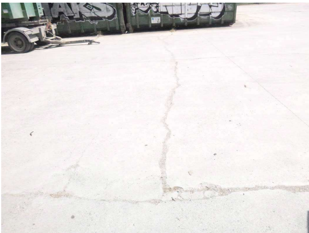
Figure 6 : Fissuration du dallage, éclats de béton.
