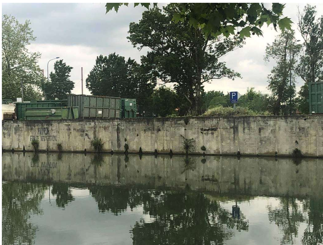
Figure 55 : Vue de la partie F (renseignée sur le plan d'implantation des désordres) du mur de soutènement, présence d'humidité et de végétation le long des joints de dilatation.
