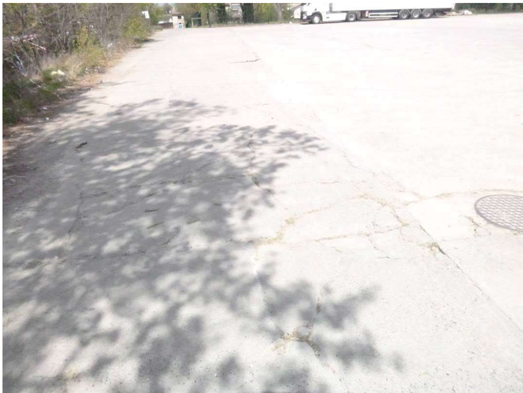
Figure 8 : Fissuration du dallage, présence d'un regard, éclats de béton.
