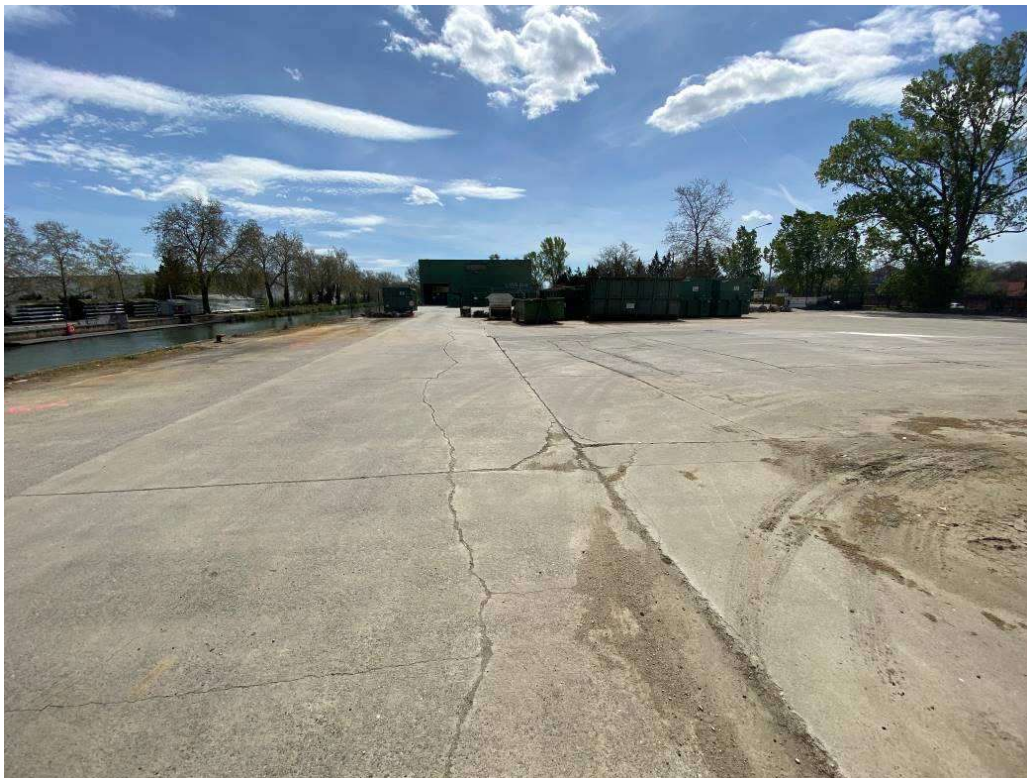
Figure 25 : Fissuration du dallage, éclats de béton aux angles de plusieurs dalles.
