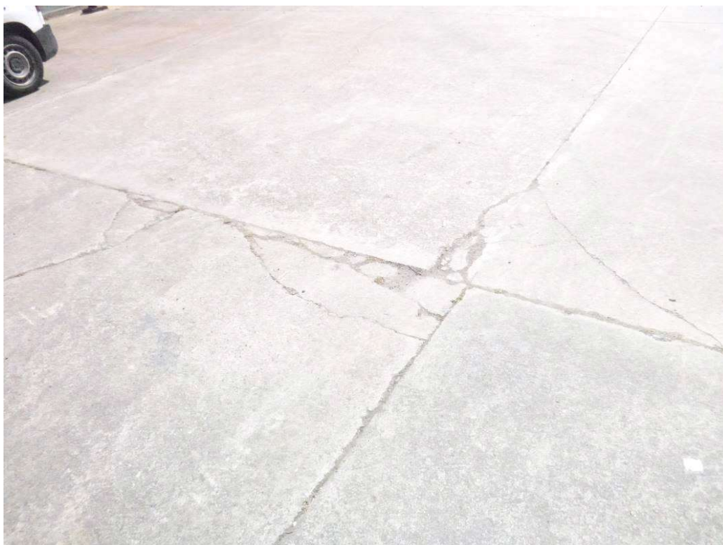
Figure 20 : Eclats de béton aux angles de plusieurs dalles.
