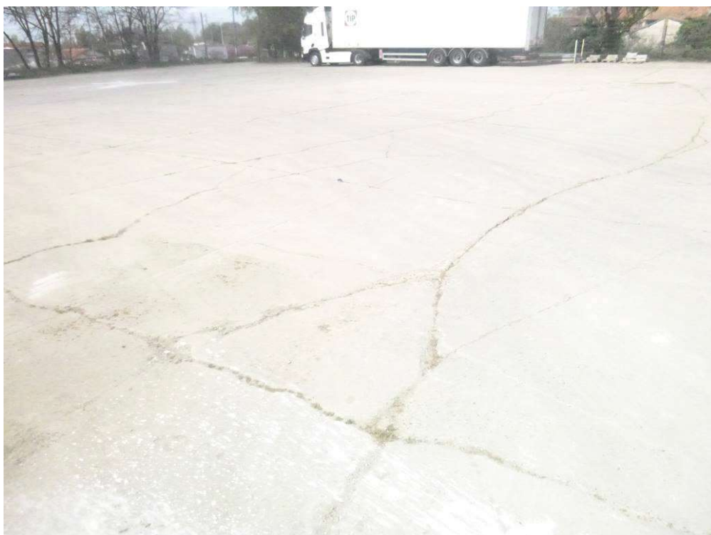
Figure 29 : Fissuration du dallage, éclats de béton.
