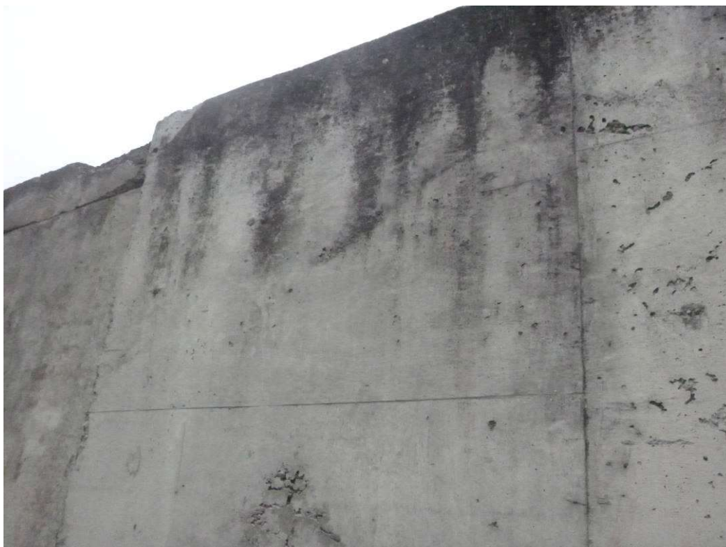
Figure 38 : Eclat de béton au niveau de l'arase du mur.
