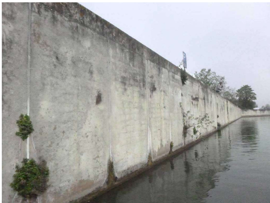
Figure 47 : Vue vers le nord, présence de végétation et d'humidité le long du joint entre panneaux.
