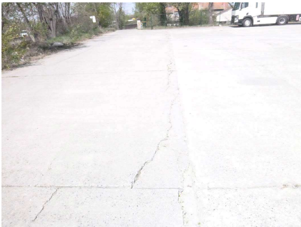
Figure 10 : Fissuration du dallage, éclats de béton.
