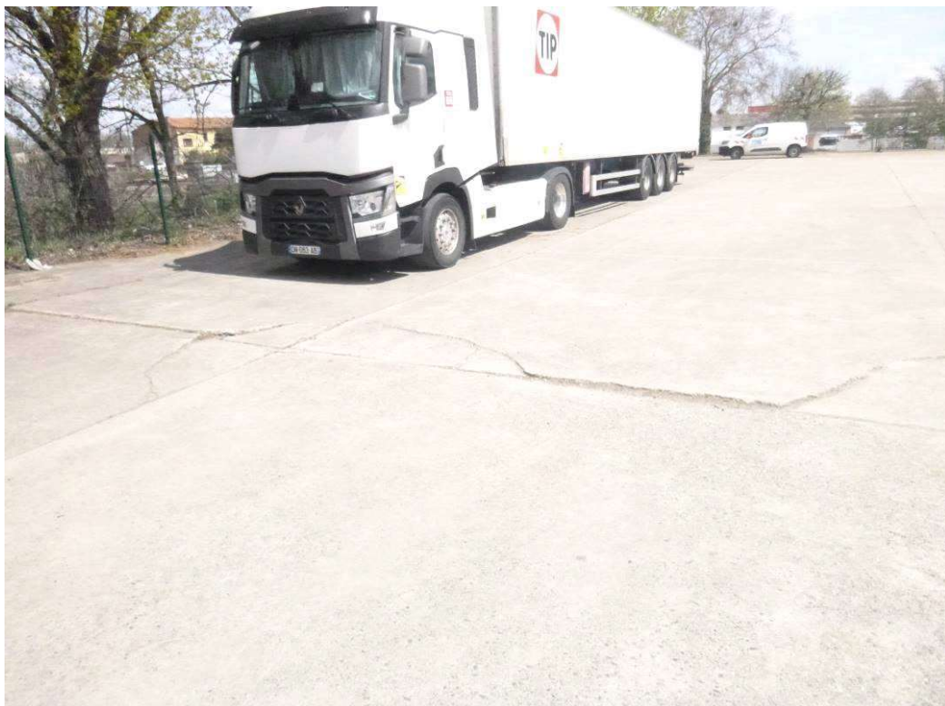
Figure 14 : Fissuration du dallage, éclats de béton.
