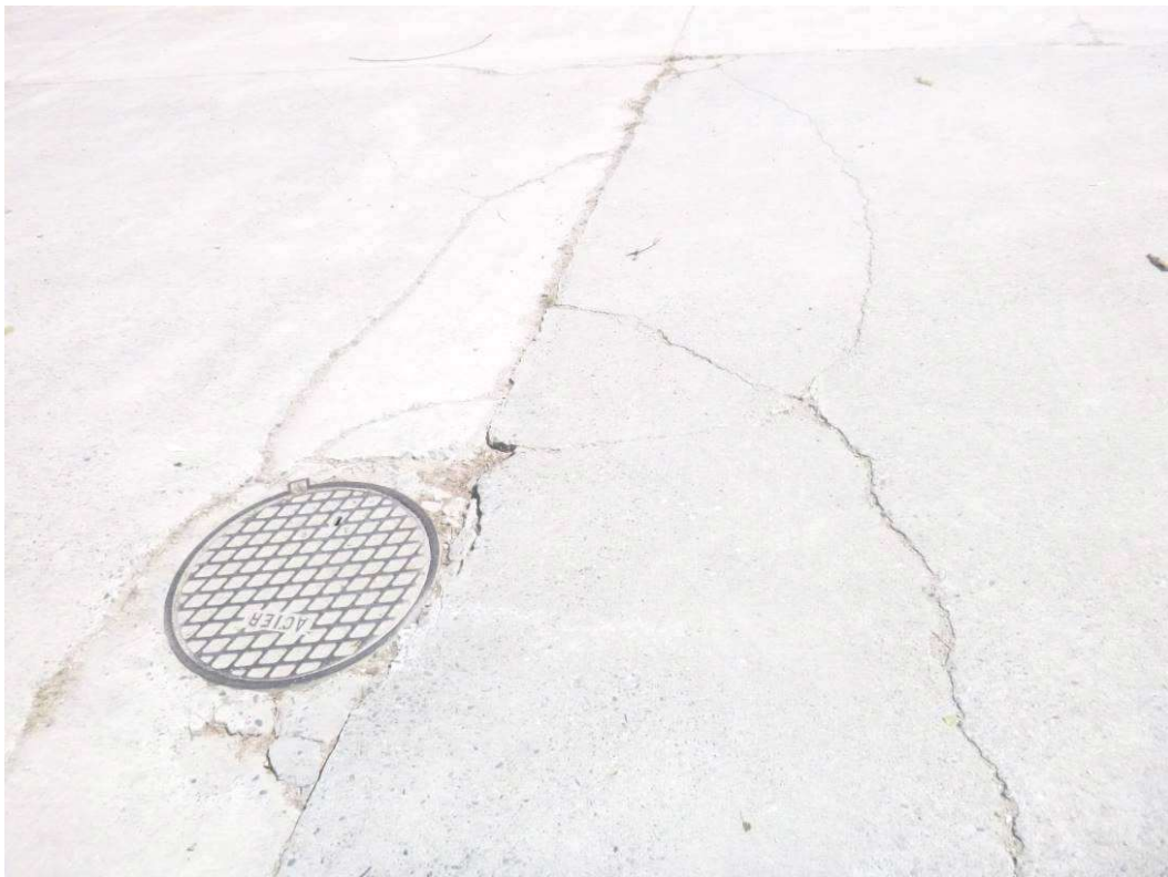
Figure 7 : Fissuration du dallage, présence d'un regard, éclats de béton.
