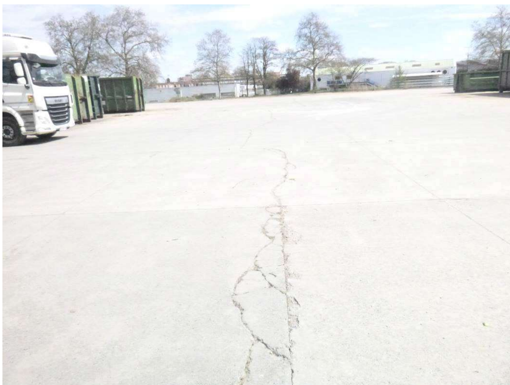
Figure 5 : Fissuration du dallage, éclats de béton.
