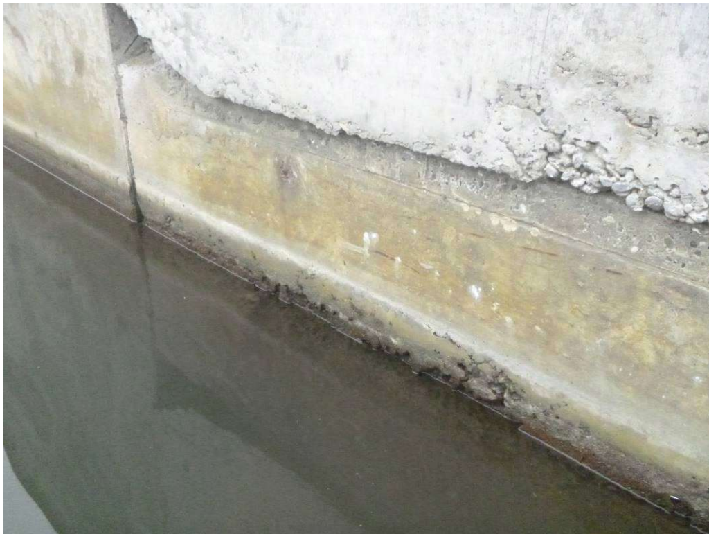
Figure 40 : Nid de cailloux au niveau de la zone de marnage.
