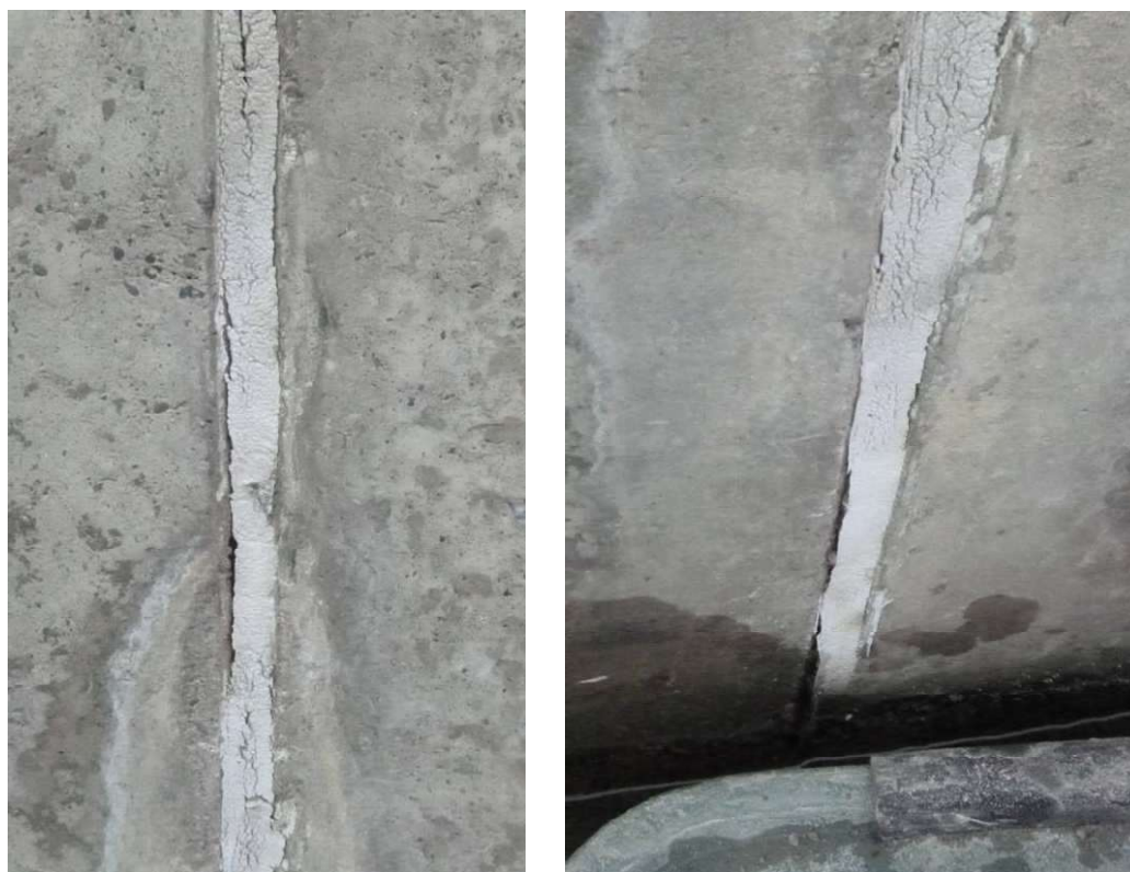
Figure 42 : Usure du joint entre panneaux, traces de calcite.
