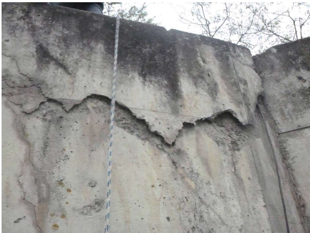
Figure 36 : Décroché de l'arase du mur : fracture avec rejet, fissures et microfissures.
