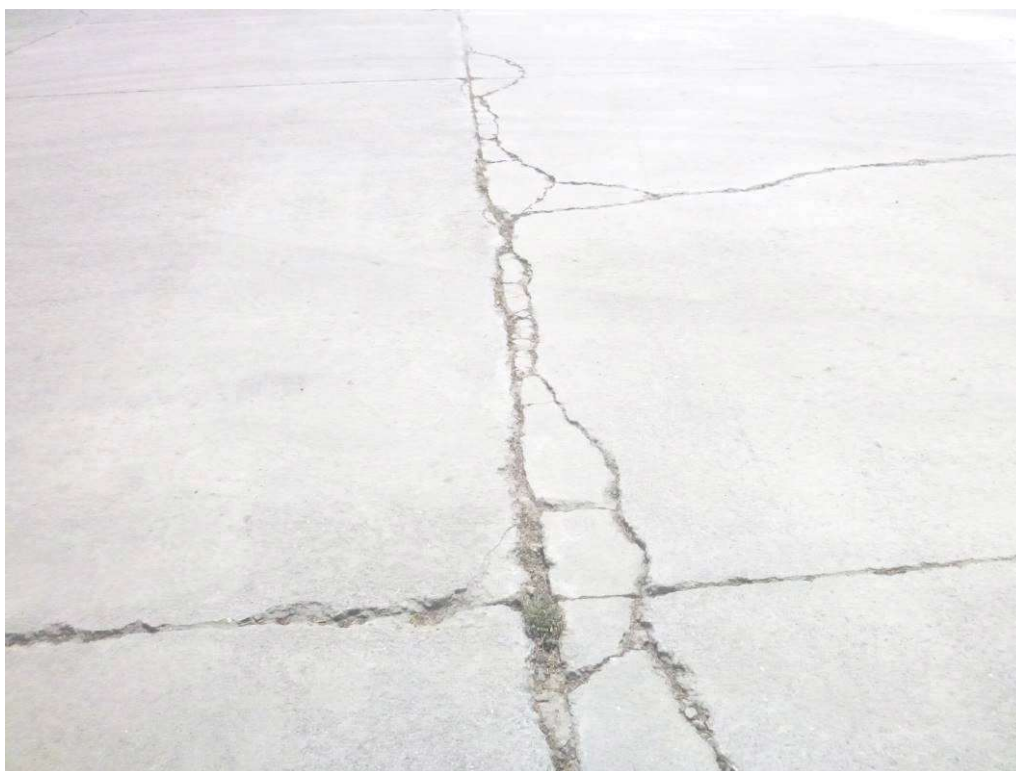
Figure 27 : Fissuration du dallage, éclats de béton aux angles de plusieurs dalles.
