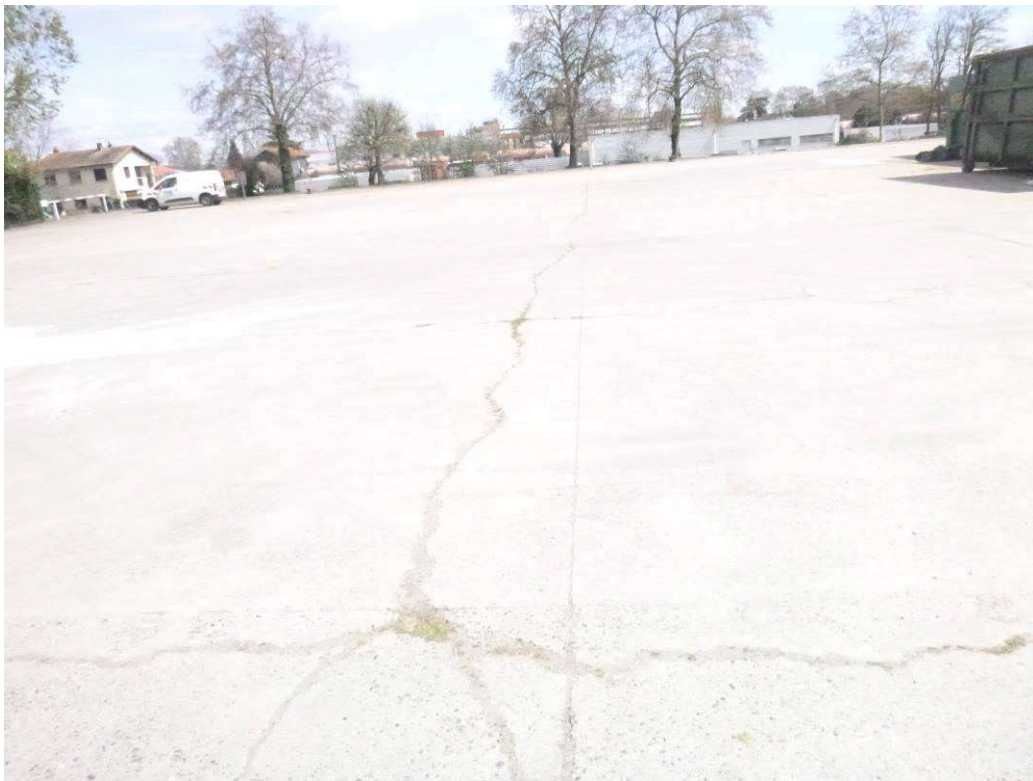
Figure 13 : Fissuration du dallage, éclats de béton.
