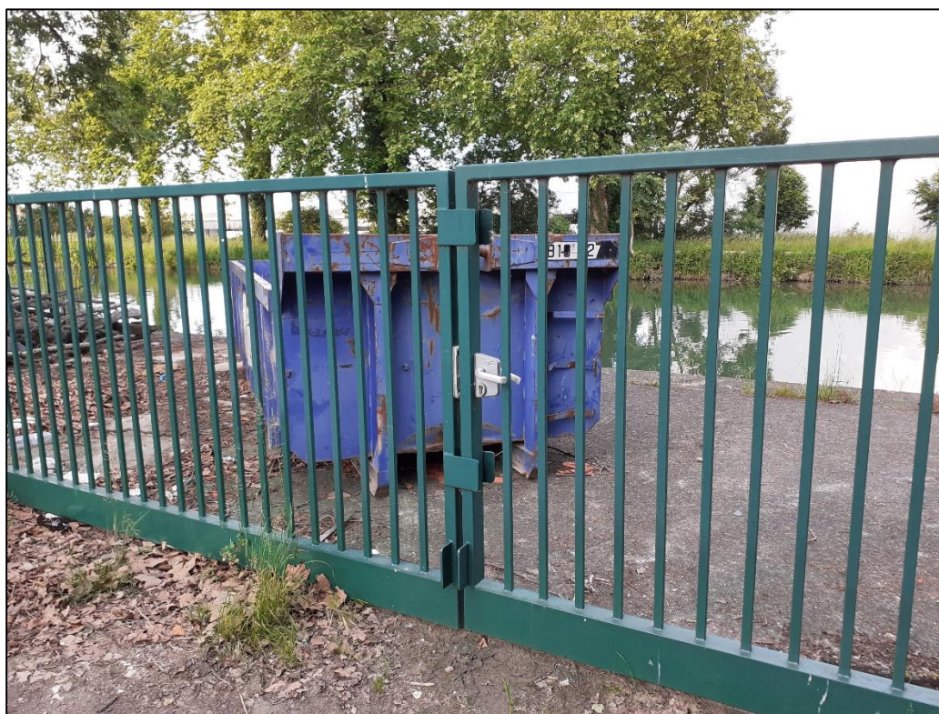
Figure 13: Quai Midinet, fermé d'un portail et clôture, et sa plateforme
