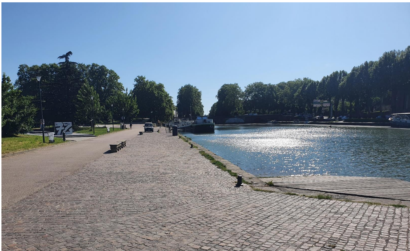
Figure 20 : Port de l'Embouchure, vue vers l'est du quai, terre-plein pavé sur 5m60 et rampe
