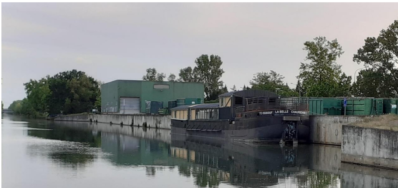
Figure 11 : vue du quai fluvial depuis l'écluse de Lalande.
