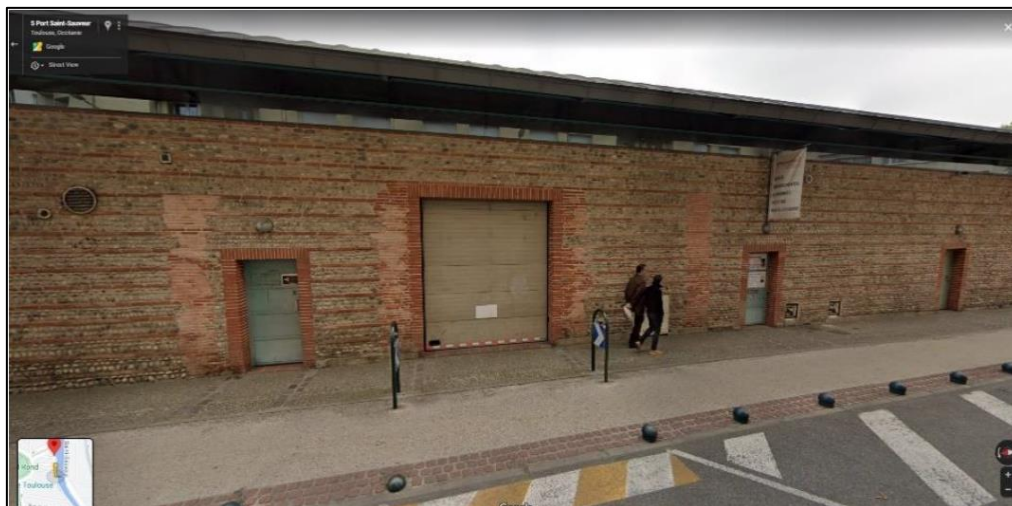
Figure 28 : Accès au local de la capitainerie par la route (traversée de la piste cyclable)
