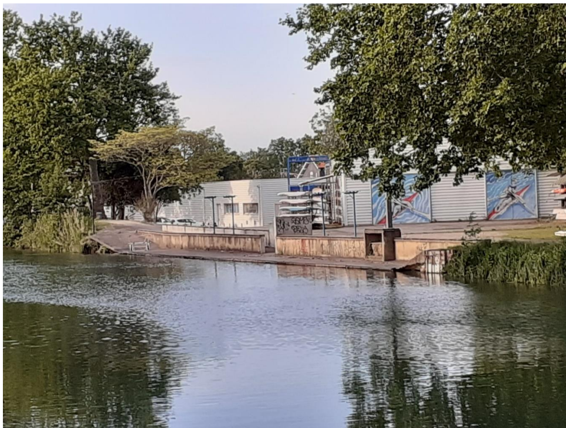
Figure 17 : ponton bas, bâtis et zones de stockage de TASL, en rive droite du canal, face à la zone N°2.
