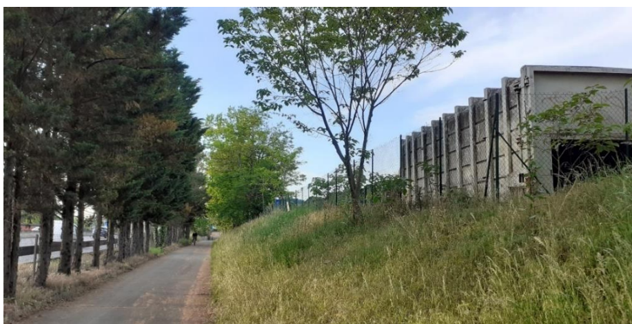
Figure 10 : Piste cyclable en contrebas des sites fluviaux de Lalande (à droite : vue de la zone 2)
