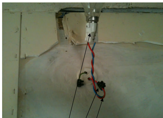
Conducteur sans protection donino et douille de chantier
