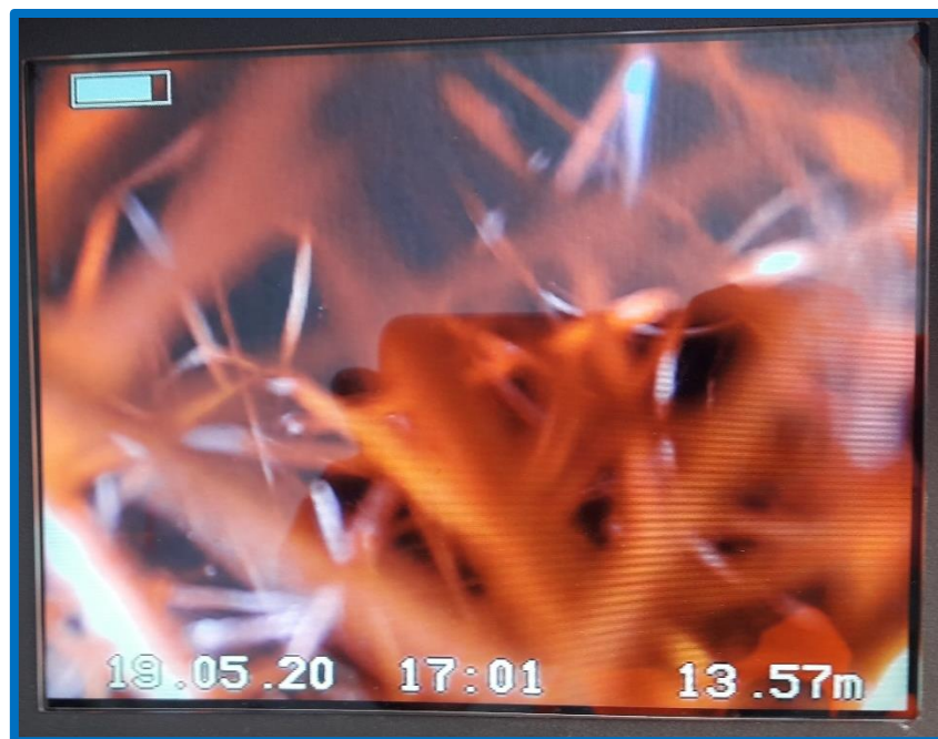
Figure 4 : Présence de racines à l'intérieur d'une canalisation (REP6 en direction de l'aval)
