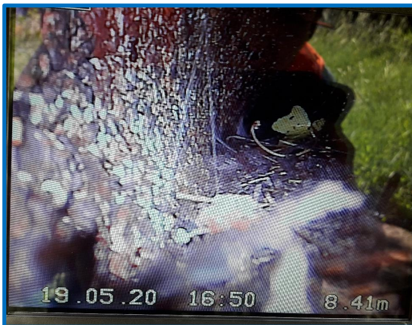
Figure 5 : Présence de terre et de racines à l'intérieur d'une canalisation (REP3 en direction de l'aval)
