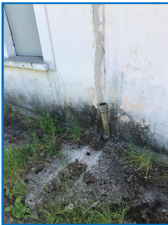
Figure 3 : Envahissement de la végétation sur la partie berge (au niveau de l'ouvrage PUI1) / Gouttière endommagée
