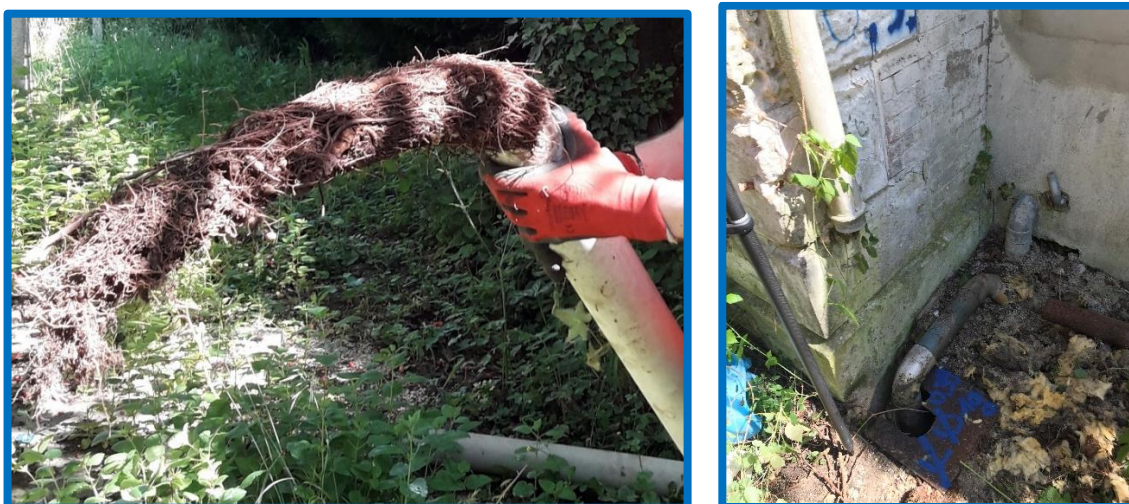
Figure 1 : Présence de racines à l'intérieur d'une gouttière / Gouttière endommagée
