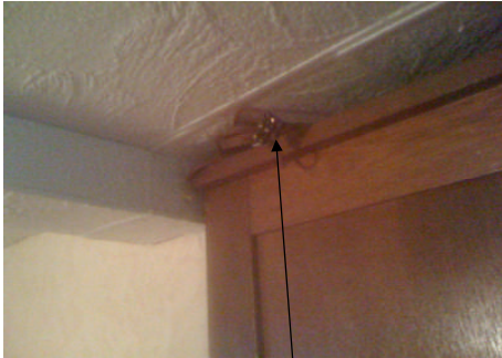
Dans entrée conducteur sans protection et domino
