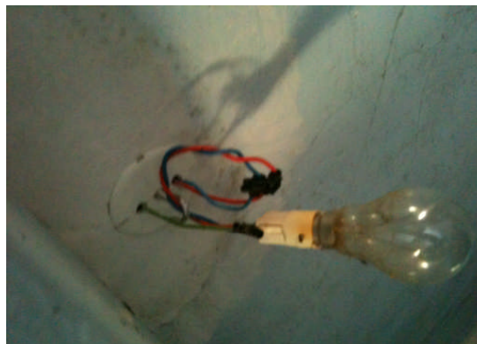
Conducteur sans protection donino et douille de chantier
