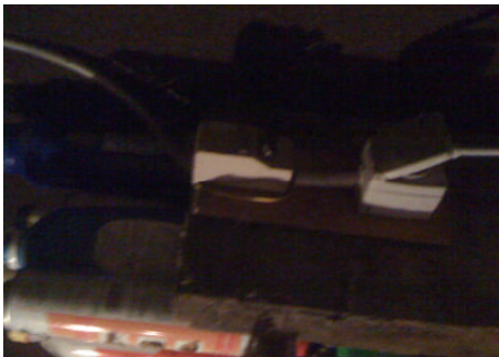
Dans entrée conducteur sans protection et domino
