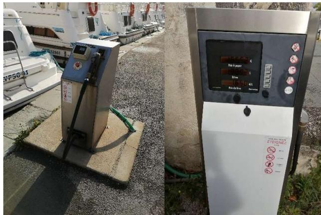
Pompe à gazole (à gauche), distributeur et cuve de stockage du gazole dans son bac de rétention (à droite)
